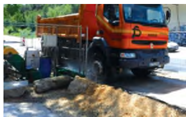
Exemple de pédiluve mobile en entrée de chantier (source : ville de Montpellier)
